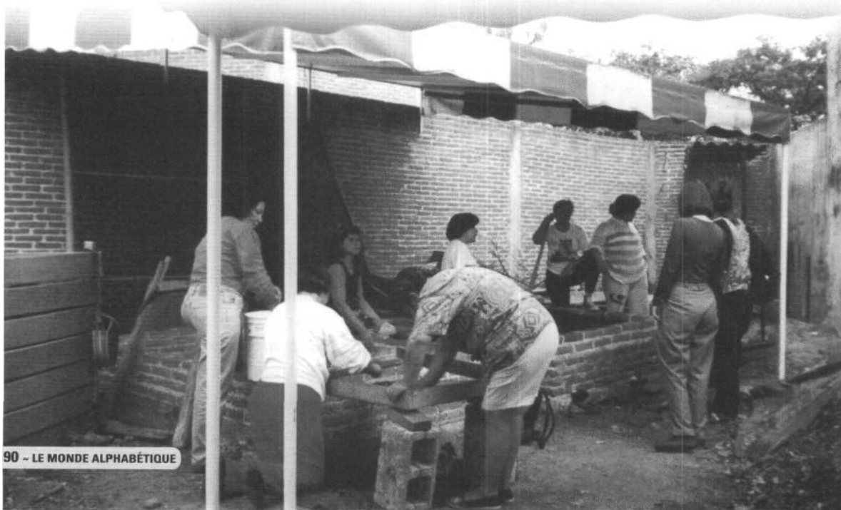
Construction d'un centre de femmes au Mexique
