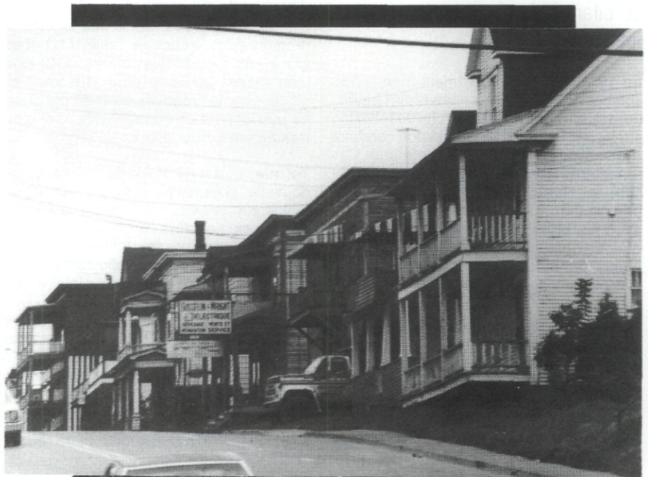
La réfection de la rue Saint-Louis
