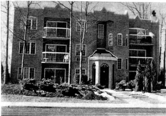
Immeuble à appartements
