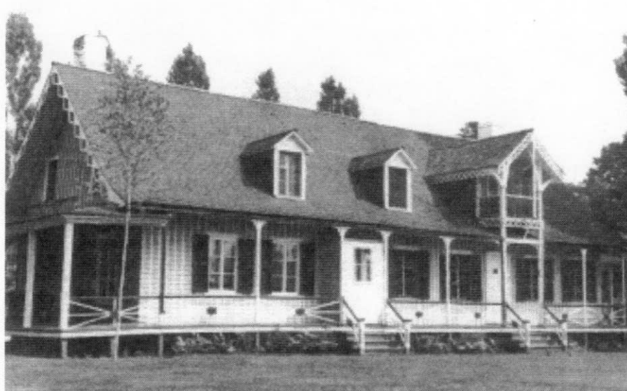
Le bureau de l'agent seigneurial de Lotbinière, situé à Leclercville et construit vers 1850. Les descendants des Joly de Lotbinière y habitent toujours. (ANC. PA-38712.)
