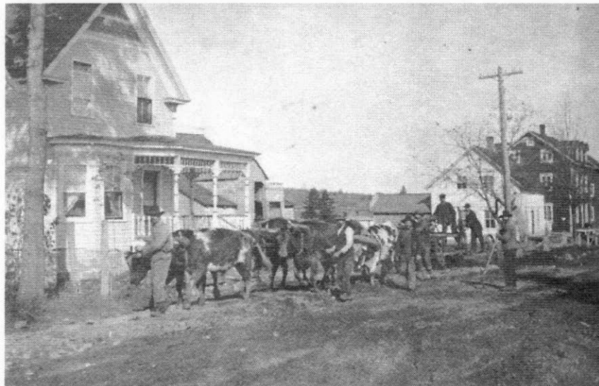
La construction de l'aqueduc en 1908.
