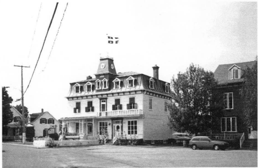
L'ancien magasin général «Normand» situé sur la rue Principale à Saint-Antoine-de-Tilly.
