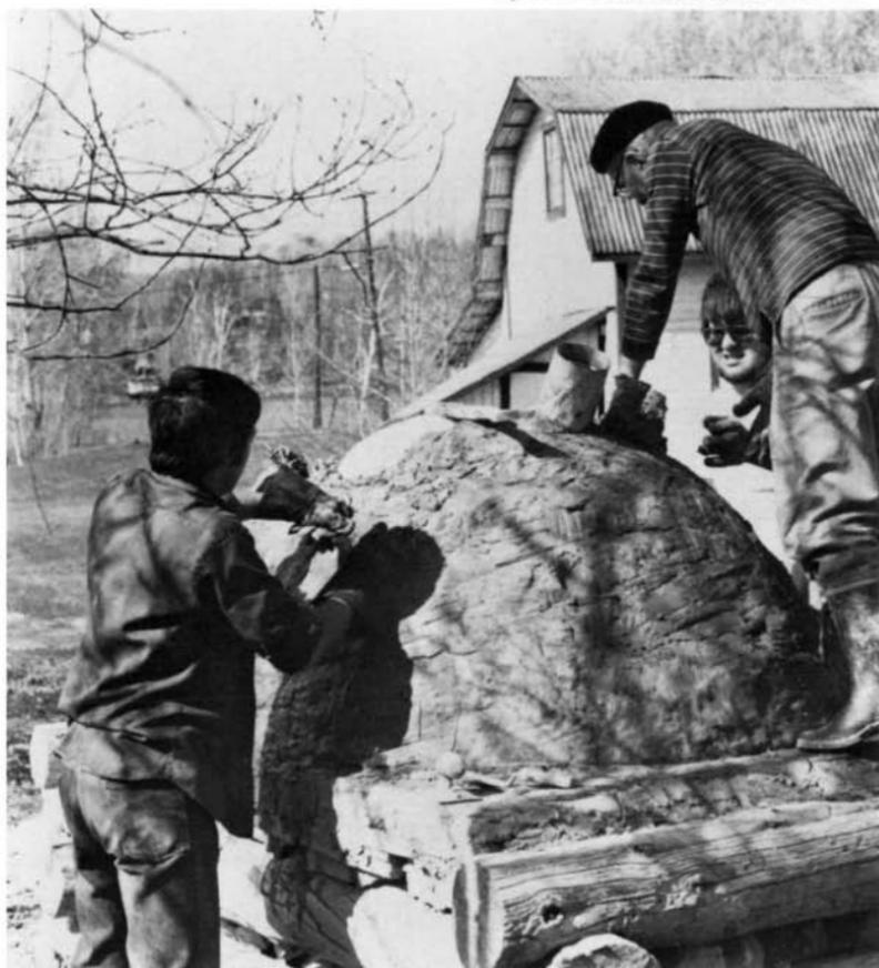
porte (sous le bois de chauffage), et la fumée produite par la combustion doit se diriger vers l'extérieur par la même porte. Un four sans tuyau prendra plus de temps à se réchauffer mais conservera sa chaleur plus longtemps que le four à tuyau.
