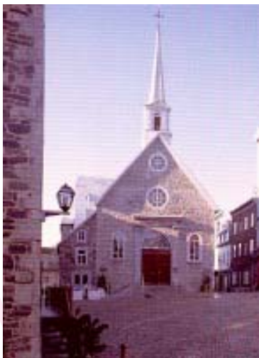
L'église Notre-Dame-des-Victoires, 32 rue Sous-le-Fort, à Québec.
